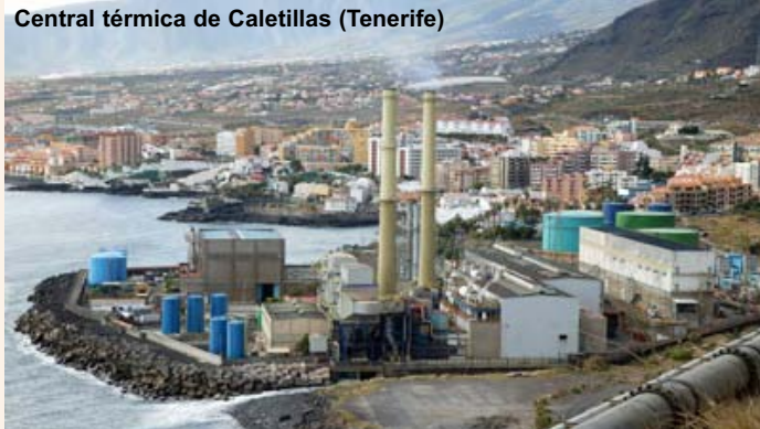
Central térmica de Caletillas (Tenerife)
