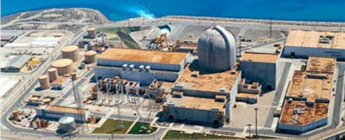
Central nuclear de Vandellós-II (Tarragona)
