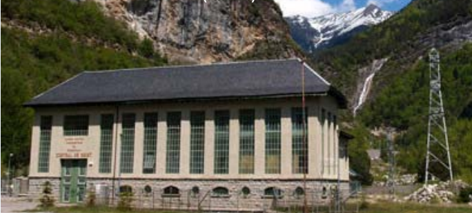
Central hidráulica de Senet (Lérida)
