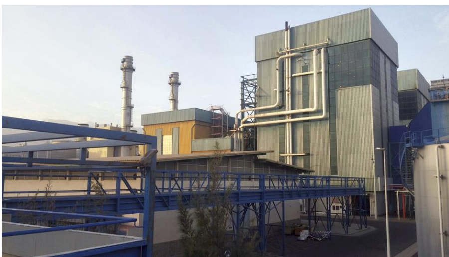
Central de Granadilla, en el sur de Tenerife, una de las nueve centrales de Endesa en Canarias.
