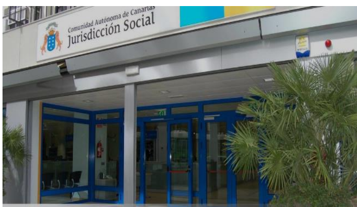
Juzgado de lo Social (Edificio Filadelfia) en Santa Cruz de Tenerife.
