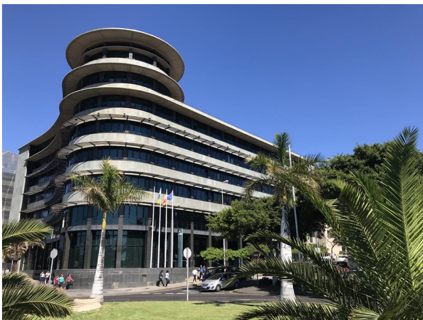
Edificio de Usos Múltiple II del Gobierno de Canarias en Santa Cruz de Tenerife.
